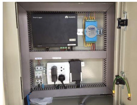
ชุดควบคุมการผลิตของอินเวอร์เตอร์
